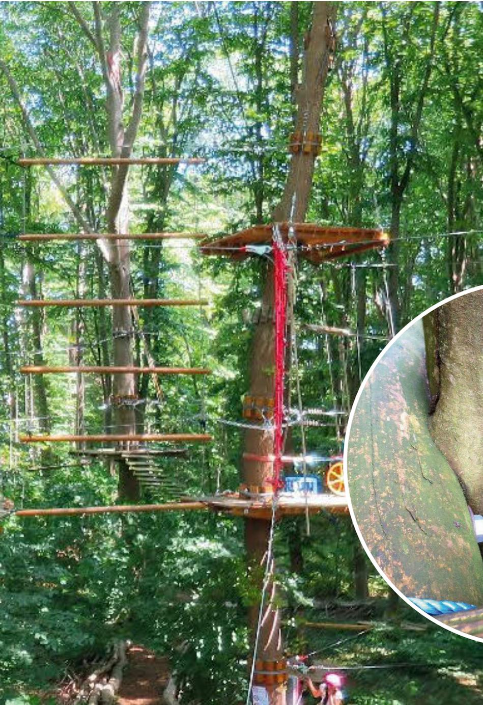
// Abb. 1: Hier hängen die Plattformen an Drahtseilen, die an geeigneten Astgabeln befestigt werden. //
