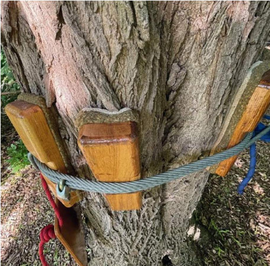
// Abb. 7: Die Korkschicht erleichtert die Montage und wirkt anhaftend, kompensierend und atmungsaktiv. //
