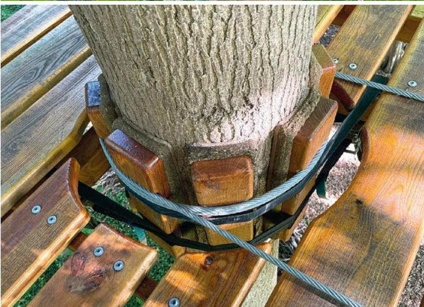
// Abb. 4 und 5: Das seitliche Verdrehen der Plattform soll durch eine L-förmige Anordnung der Kanthölzer verhindert werden. Die L-Form wird mithilfe von Zurrbändern mit Druckratschen am Stamm fixiert. //
